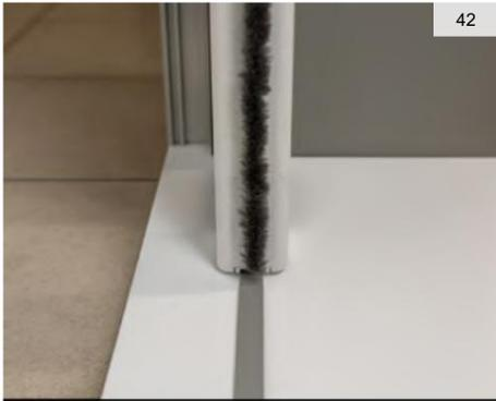
Dégraissier et sécher la surface de fixation avant de coller l'adhésif double face : l'adhésion complète est obtenue au bout d'au moins 24 heures.
