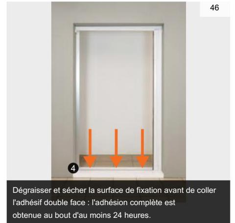
Dégraissier et sécher la surface de fixation avant de coller l'adhésif double face : l'adhésion complète est obtenue au bout d'au moins 24 heures.
