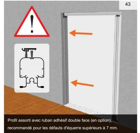
Profil assorti avec ruban adhésif double face (en option), recommandé pour les défauts d'équerre supérieurs à 7 mm.
