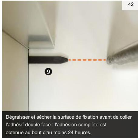
Dégraissier et sécher la surface de fixation avant de coller l'adhésif double face : l'adhésion complète est obtenue au bout d'au moins 24 heures.
