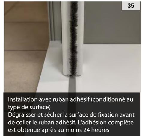
Installation avec ruban adhésif (conditionné au type de surface)
