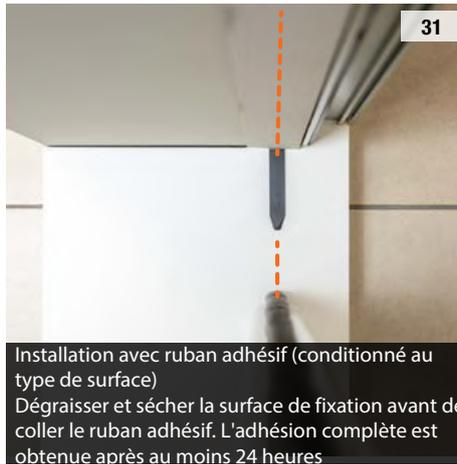
Installation avec ruban adhésif (conditionné au type de surface)
